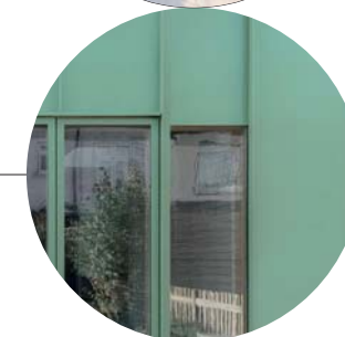
nové objekty ocelová konstrukce, falcovaný plech, barva zelená RAL6011, dřevěná okna, dveře a podhledy
