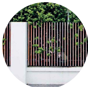
oplocení vstupního prostoru podezdávka, bílá omítka, dřevěné lamely
