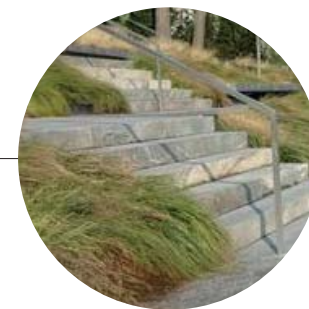
kamenné schody schodnice - kamenné bloky podesty - kamenná dlažba skládaná
