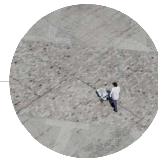
kamenná dlažba skládaná, řádkový vzor pootočený, vymezení linie vstup-schodiště
