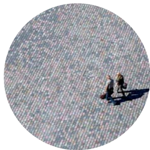
kamenná dlažba skládaná, řádkový vzor, rozptylová plocha v areálu zoo
